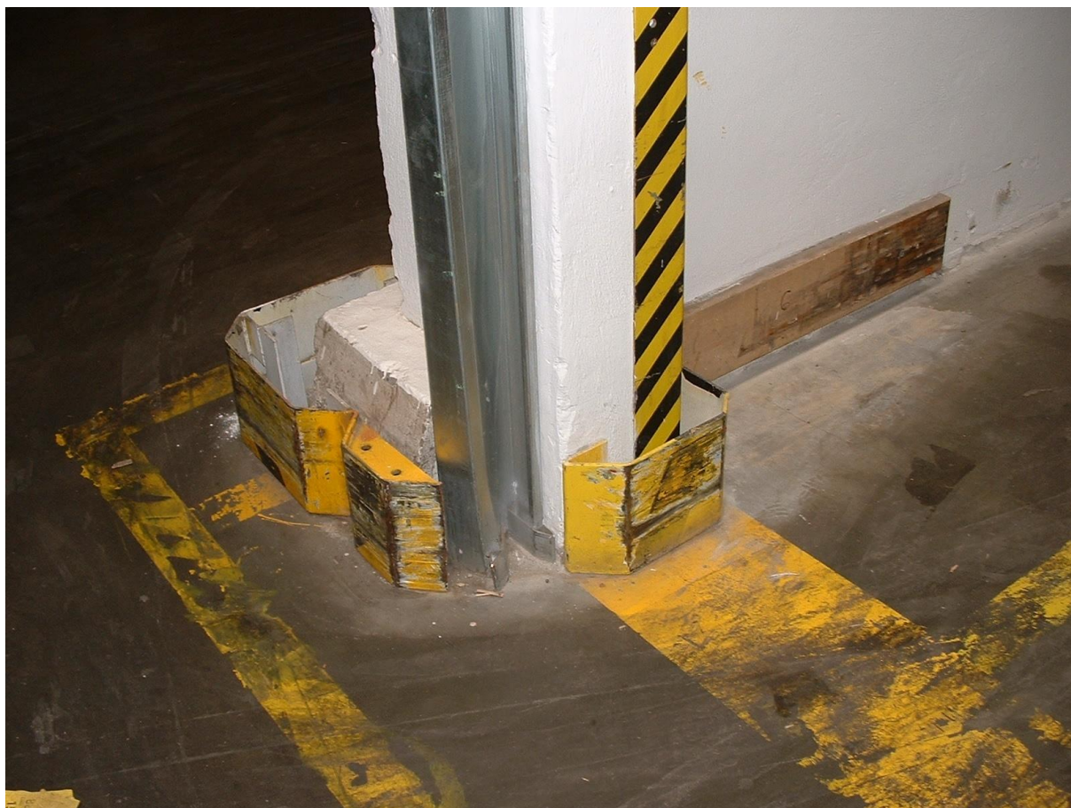
G1 sz. ábra. Elégtelen mechanikai védelem miatt sérült vezetősin
