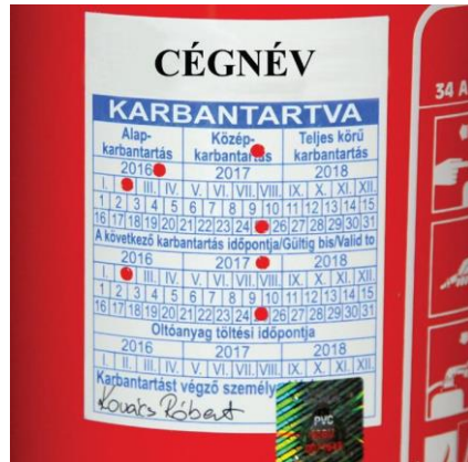
Karbantartást igazoló címke felhelyezése OKF azonosító jellel
