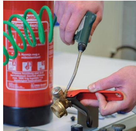
A fejszerelvény kifűvése sűrített levegővel
