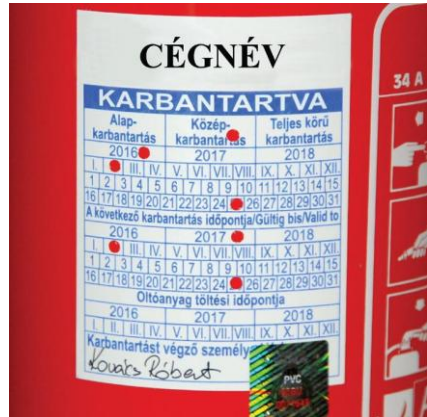
Karbantartást igazoló címke felhelyezése OKF azonosító jellel
