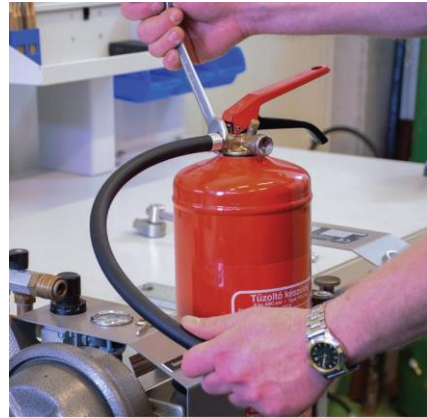
Tömlőszerelvény leszerelése
