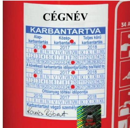
Karbantartást igazoló címke felhelyezése OKF azonosító jellel
