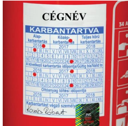
Karbantartást igazoló címke felhelyezése OKF azonosító jellel
