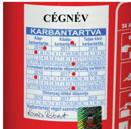
Karbantartást igazoló címke felhelyezése OKF azonosító jellel
