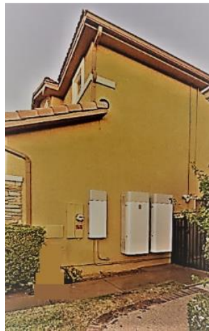
4. ábra: Példa az energiatároló kialakítására kültéren, homlokzaton
