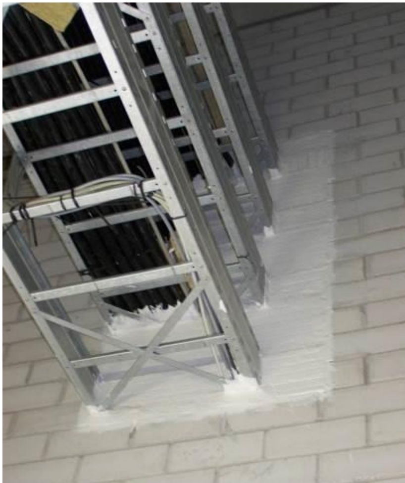
G4 sz. ábra. Villamos vezeték tűzgátló lezárása szakszerűen kivitelezett lágyzárással (kétoldalt tűzvédelmi bevonattal ellátott közetgyapottal)
