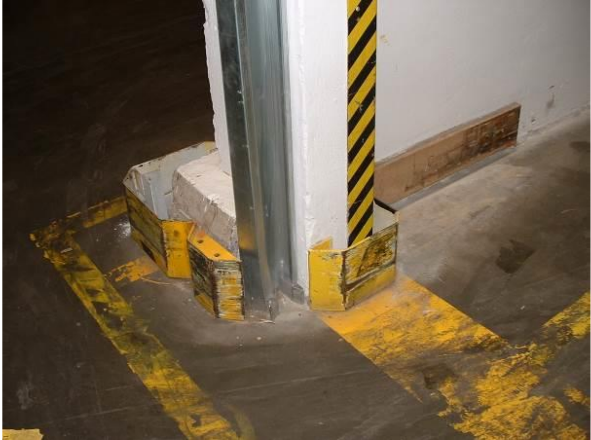
G1 sz. ábra. Elégtelen mechanikai védelem miatt sérült vezetősín
