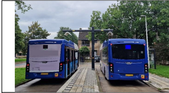
5. ábra példa a pantográfós töltőberendezésre
